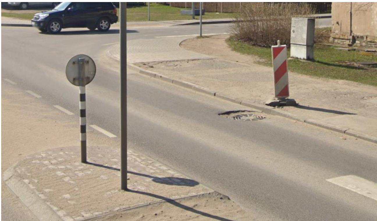
2 pav. Važiuojamosios dalies būklė ties vandens surinkimo šulinėliais
